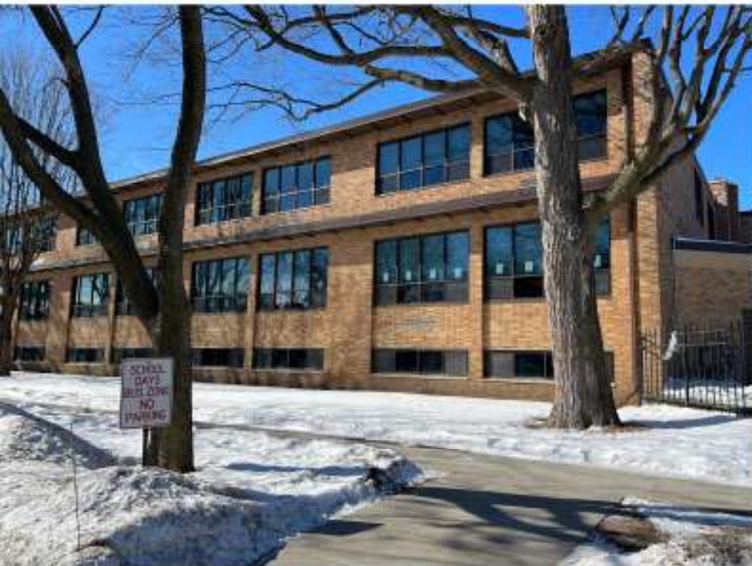
630 WAYZATA BLVD E
